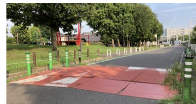
ハンプ(凸部):車の速度を落とすことを目的とし、道路に設置されるものです。
